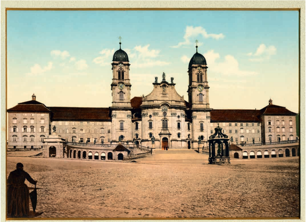
Auf diesem Autochrom von ca. 1910 haben die meisten Fenster an der Klosterfassade eindeutig keine Läden (KAE, Foto 1.0302.0036).
