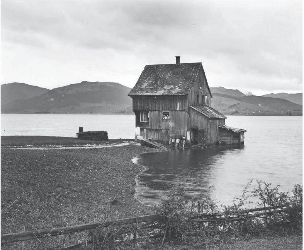
Ein Haus in Willerzell, das langsam überflutet wird (KAE, Foto 1.0903.0004).
